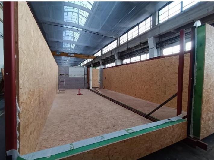
La préfabrication des modules 3D en atelier permet une réduction de la quantité de matériaux entrants (grands volumes calculés au plus juste, peu d'emballages, optimisation des matériaux par modélisation 3D) et des matériaux 'sortants' (réutilisation des chutes, stock de sécurité, retours usines) Les assemblages des modules sont secs et se font de manière mécanique.
